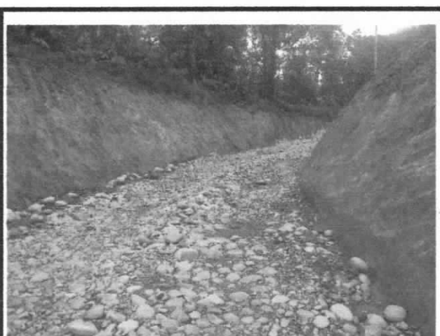
BASE EN RECEBO Y PIEDRA DE RIO
